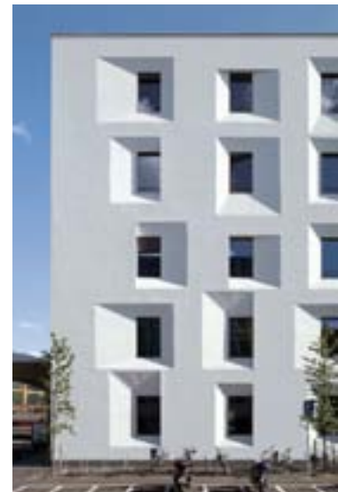
Das Prinzip des Lichtkeils inspirierte den Architekten Michael Tribus beim Umbau eines ehemaligen Postgebäudes in Bozen. © René Riller, Schlanders, IT
